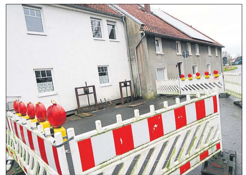
Die Warmenau-Brücke an Mettings Mühle auf der Grenze zu Niedersachsen darf künftig nur noch von Fußgängern benutzt werden.
