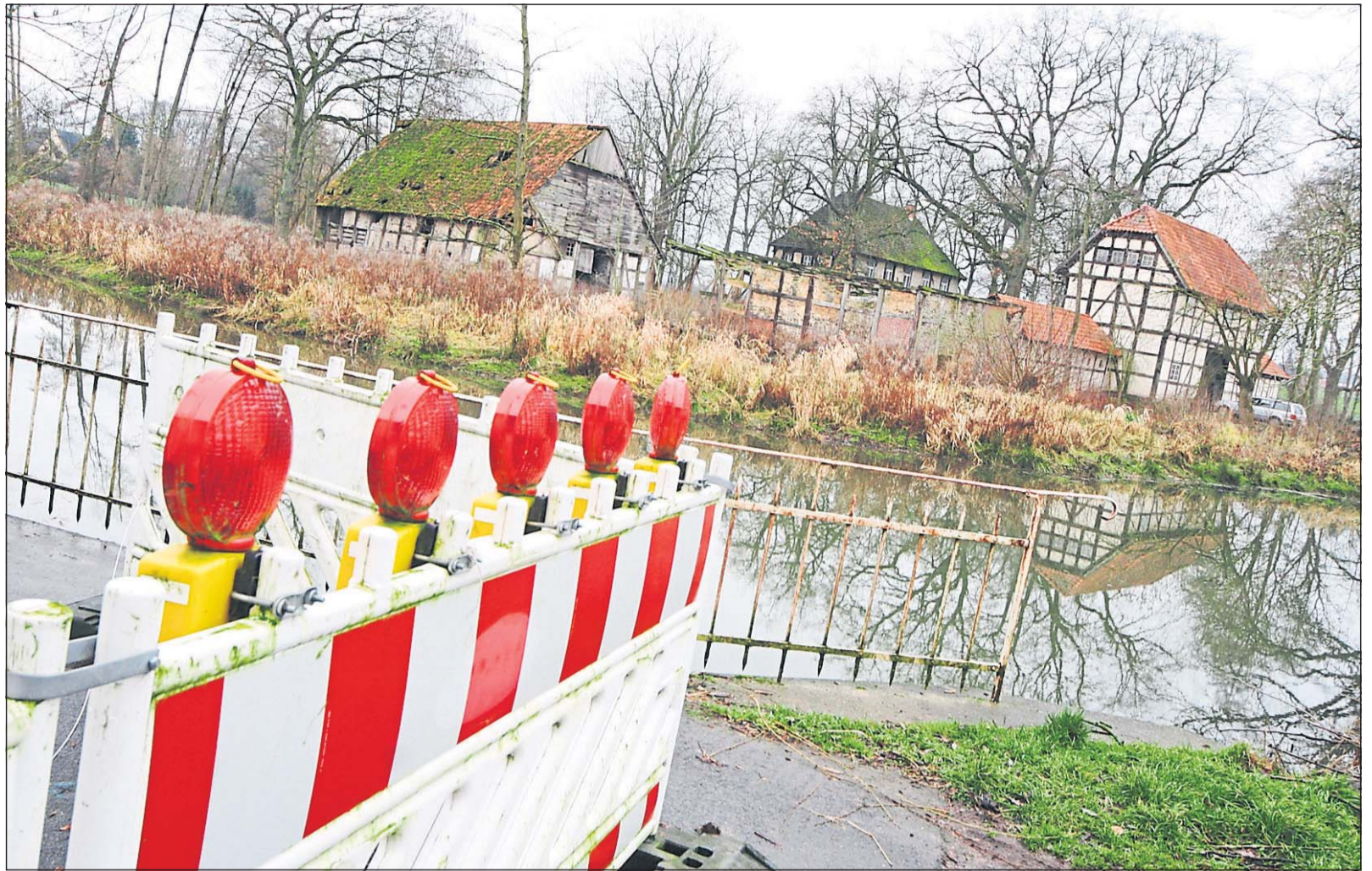
Um die Warmenau zu verlegen, hätte Graf Kerssenbrock als Besitzer des Gutes Warmenau (im Hintergrund) Grundstücke abtreten müssen.
