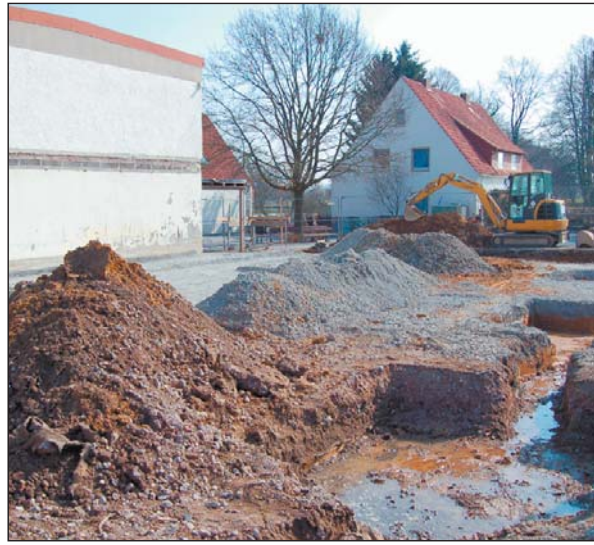
Das Platzproblem an der Grundschule Wa-Ba ist bald gelöst: Am 8. März rückte der Bagger an, nach den Sommerferien soll der Neubau fertig sein. Foto: Meyer
