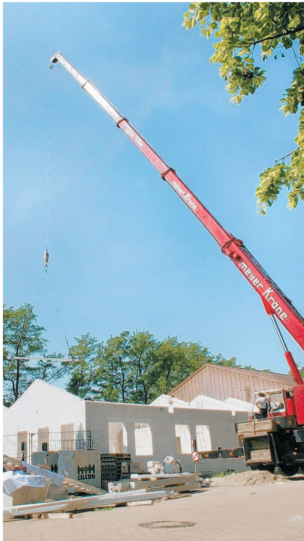
Hoch hinaus auf engstem Raum: Bei strahlend blauem Himmel haben Handwerker gestern begonnen, mit dem Kranwagen die Stahlträger auf das Dach des Kleinbahn-Museums zu setzen. FOTOS: PATRICK SCHLÜTTER
