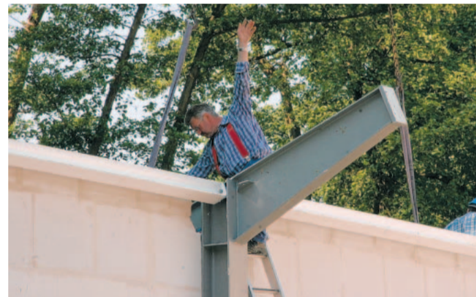
Immer langsam: Wolfgang Bönker weist mit der Hand dem Kranführer den Weg. Auf dieser Stahlkonstruktion lastet bald das Dach.
