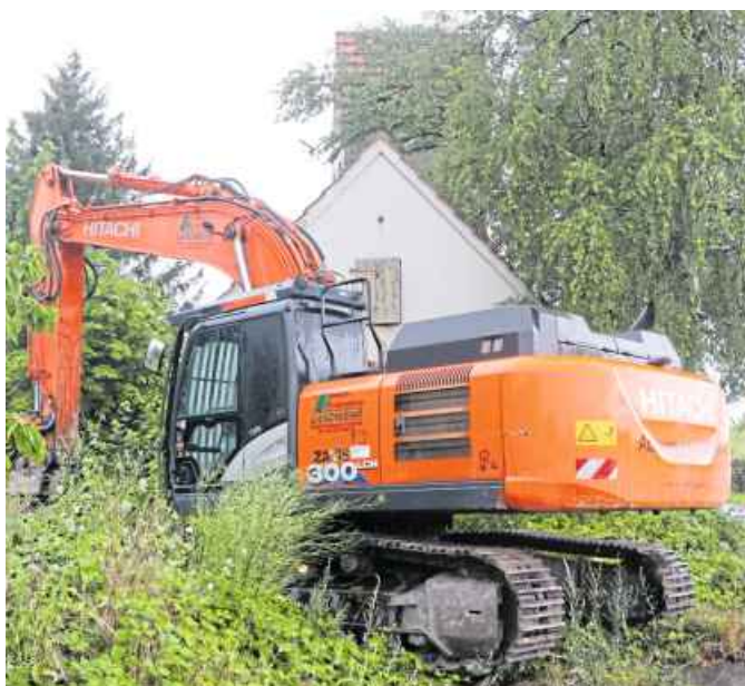
Noch in dieser Woche wird der Bagger das alte Spritzenhaus abreißen.
